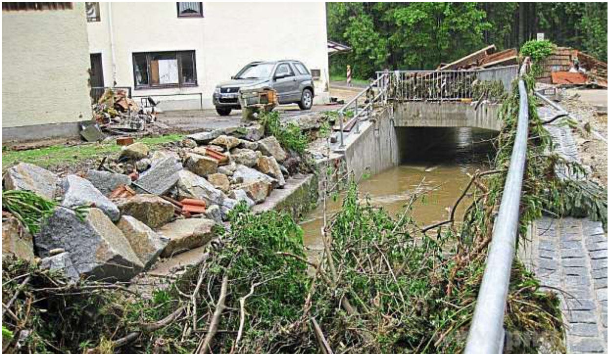
Ein Bild der Verwüstung zeigt sich an der neuen Brücke in Kerneigen. Tonnenschwere Granitblöcke vor dem Einlauf wurden wie Spielzeug herausgerissen, die Fahrbahn gibt es bestenfalls noch zur Hälfte.
