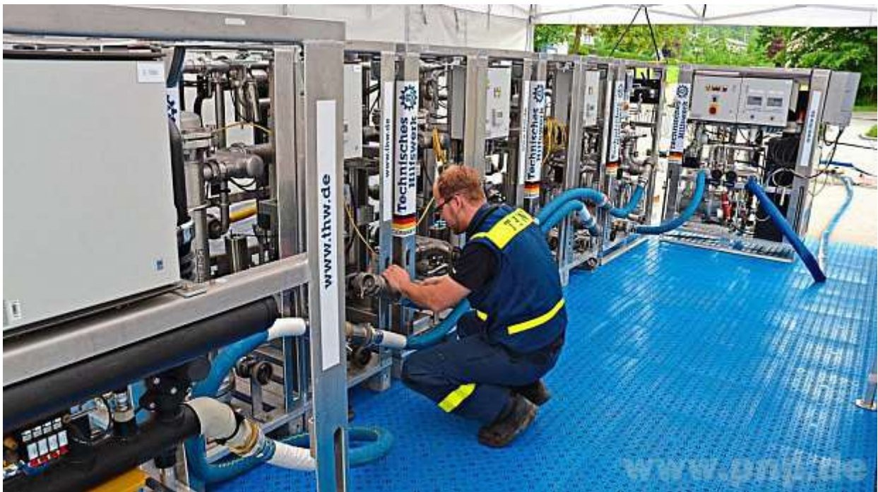
Truppführer Florian Patzelt vom THW Starnberg arbeitet an der einzigen Trinkwasseraufbereitungsanlage Bayerns, die gestern am Simbacher Freibad aufgebaut wurde. – Foto: Brodschelm
